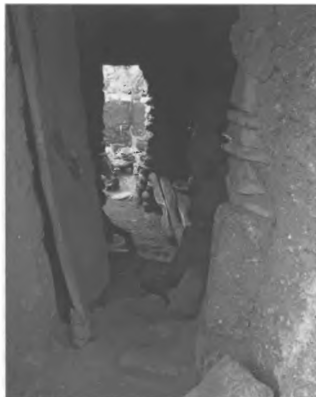
Budynek bramny, przez który wiedzie droga na podwórze.
