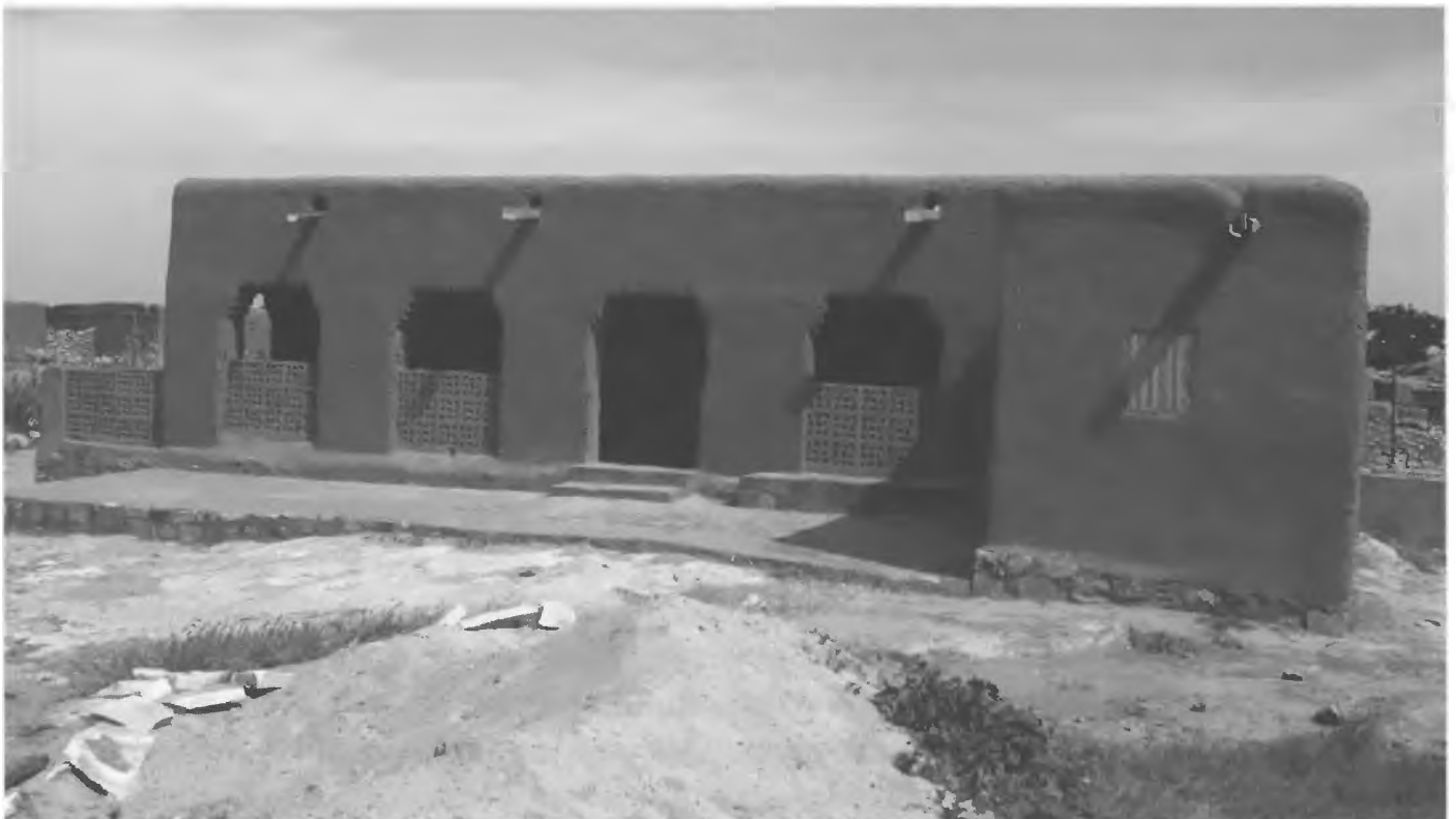
Budynek francuskiej misji etnologicznej w Ogol-Dah.
