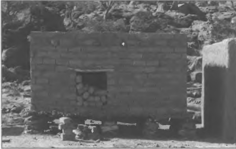
Spichlerz budowany z cegieł z dodatkiem cementu.
