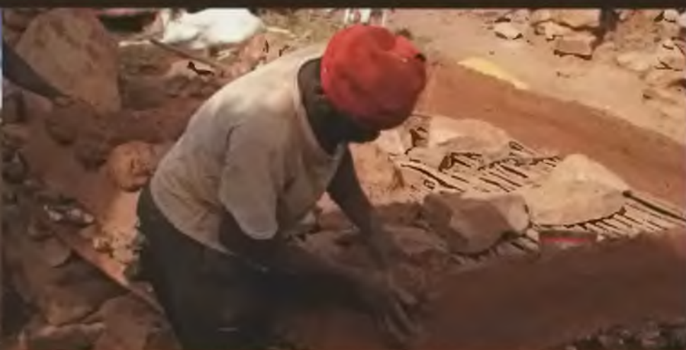
Lepienie ściany spichlerza z grudek ziemi kształtowanych w rękach w Sinnakarma
