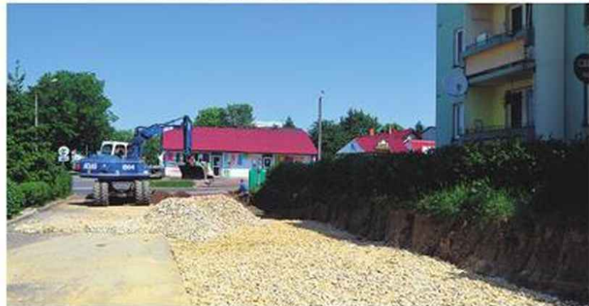
Na 130-metrowym odcinku drogi pomiędzy blokami zostanie położona kostka brukowa.
