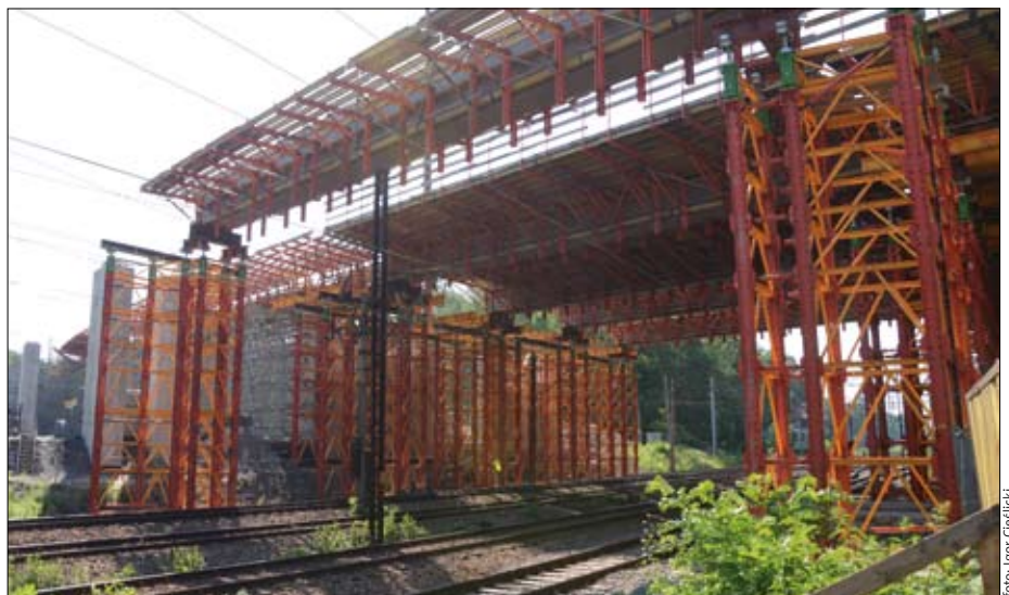
Na wiadukcie prowadzącym nad linią kolejową ruszają w lipcu betonowania
