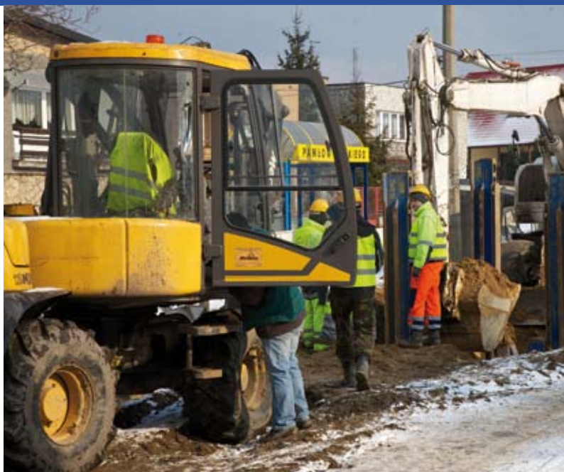
Modernizacja miejskiej sieci wodno-kanalizacyjnej
