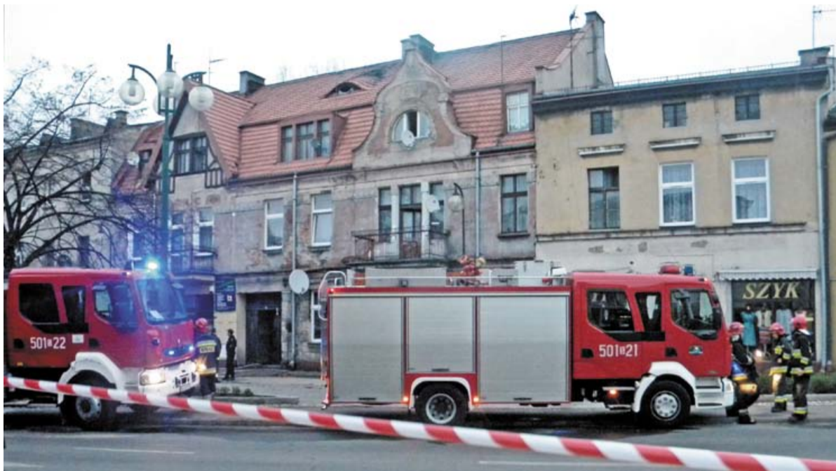
Pożar w kamienicy to wina zwarcia w instalacji elektrycznej. To częsta przyczyna zaprószeń ognia.
