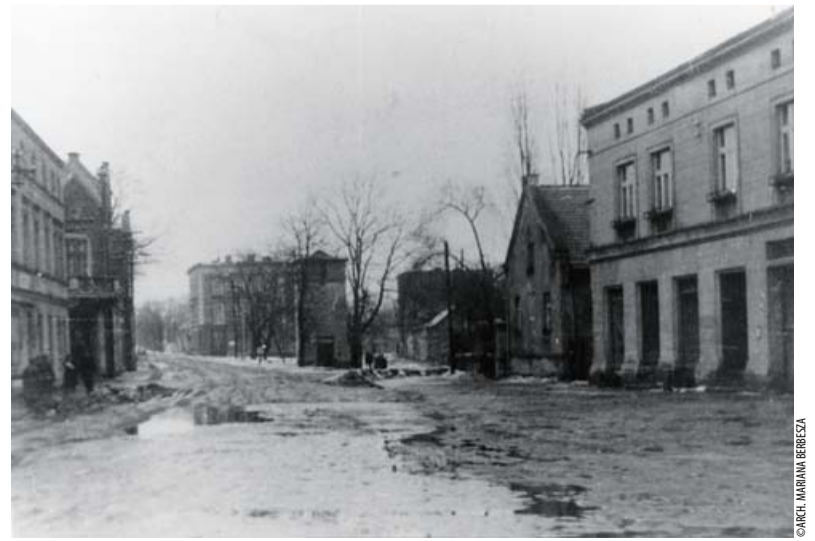
W domu p. Brelińskiego w którym mieściła się „wytwórnia win i wódek”. Budynek spłonął w styczniu 1945 r., podpalony przez sowietów. W tym miejscu obecnie znajduje się stacja paliw BP.
