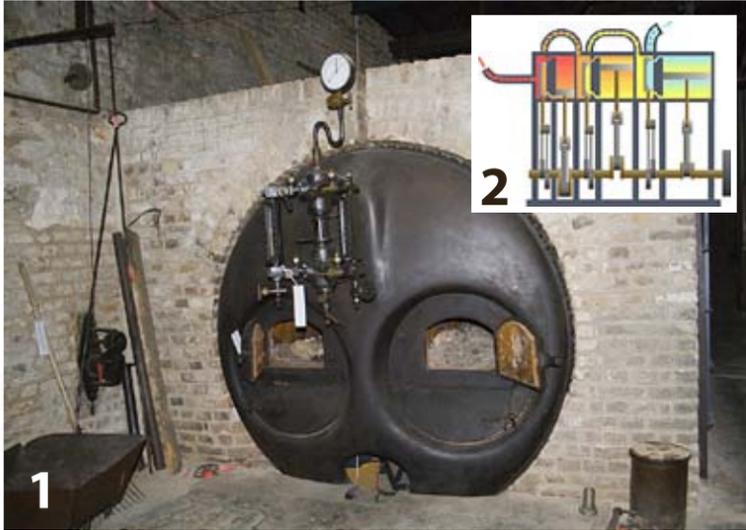
Widok przedniej strony kotła dwupłomienicowego prawdopodobnie takiego, jaki zainstalowany był w pierwszej opolskiej elektrowni – wg fot. Sozi/Wikimedia Commons. U góry: Zasada działania maszyny parowej potrójnego rozprężania wg fot. Emoscopes/Wikimedia Commons
