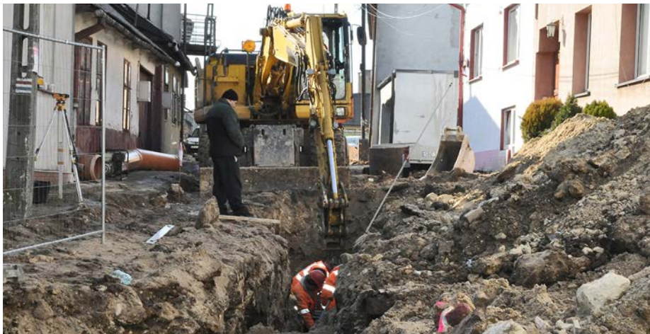
Prace wodociągowe związane z programem rewitalizacji trwają na ul. Kościelnej
