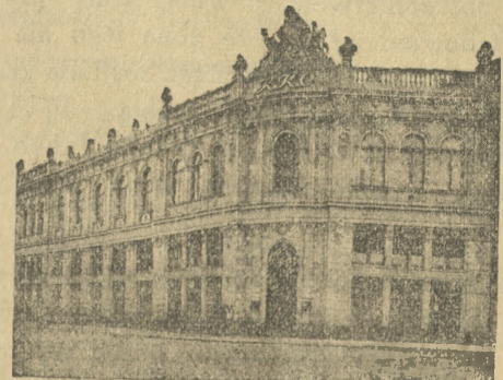
Gmach własny K. K. O. (ul. Zgoda Nr. 7. Rozmiar akcji kredytowej K. K. O. w okresie ubiegłego sześciolatka ilustruje fakt udzielenia 22.985 osobom pożyczek (zabezpieczonych materjałnie), na ogólną kwotę zł. 43.024.316 (z saldem na 1-VII bież. r. zł. 13.675.997).
