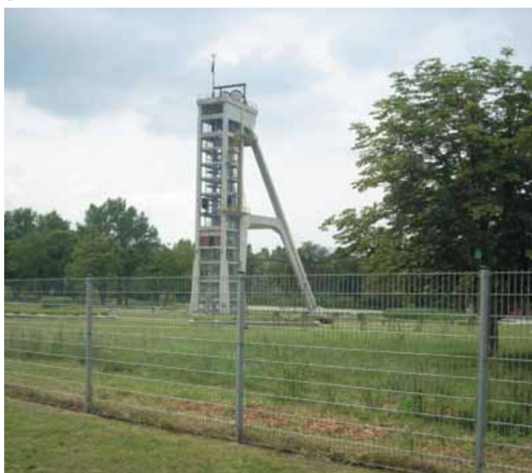
Żelbetowa wieża szybowa
