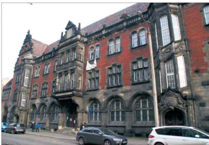
Budynek przy Piekarskiej już bez poczty.
