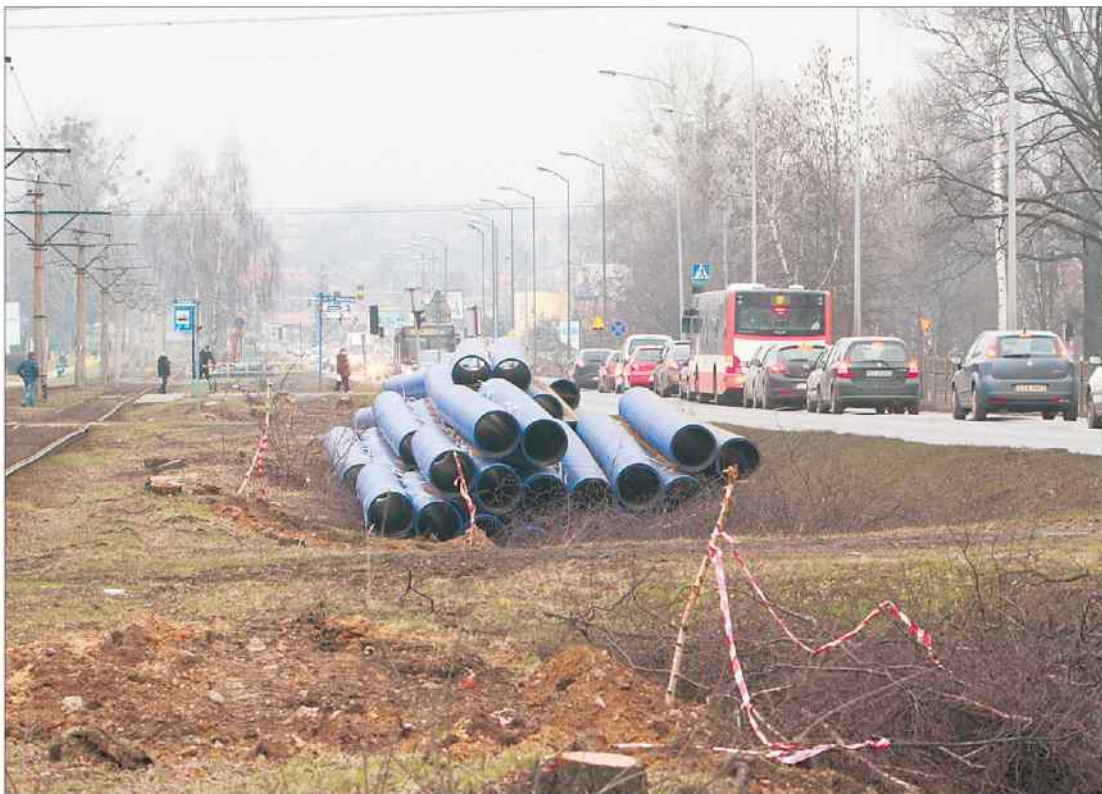
Obecnie w sąsiedztwie ulicy Strzelców Bytomskich trwają roboty przygotowawcze.
