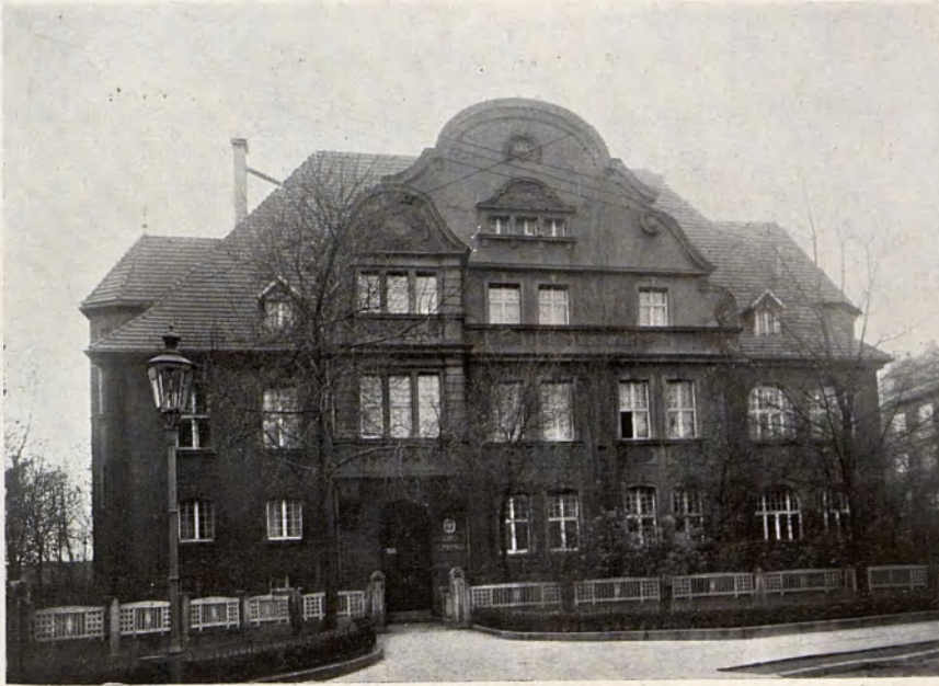
Gmach Sądu Apelacyjnego w Katowicach.
