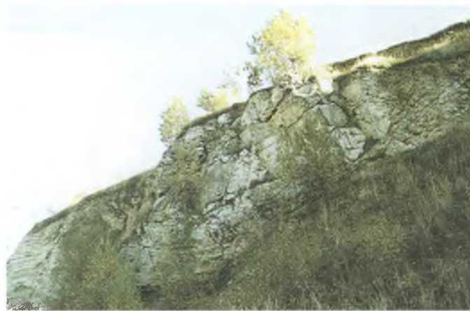
Osuwisko osadów górnourajskich w południowo-wschodniej części kamieniołomu w Żalasku. Na cienkolawicowe margle i wapienie (lewy, dolny róg zdjęcia) nasunęły się, pogięły i popękały wapienie grubolawicowe. Szczególnie silne pokruszenie zdeformowanych skał widoczne jest w prawym, górnym rogu zdjęcia
