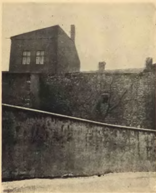
Będzin. Mur obronny przy kościele parafjalnym.
