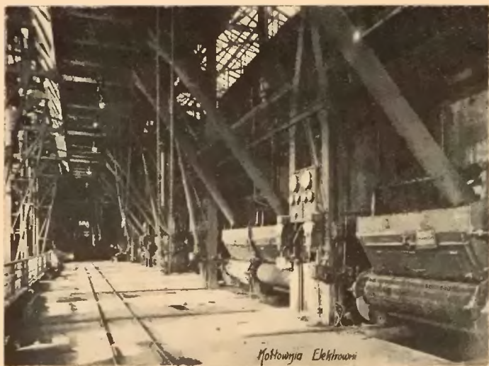
Elektrownia Okręg, Żagł. Dąbrow. Kotłownia.
