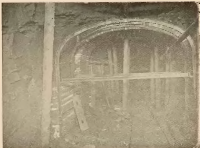
Kop. „Jowisz”. Obudowa podziemnych wyrobisk betonitami.
