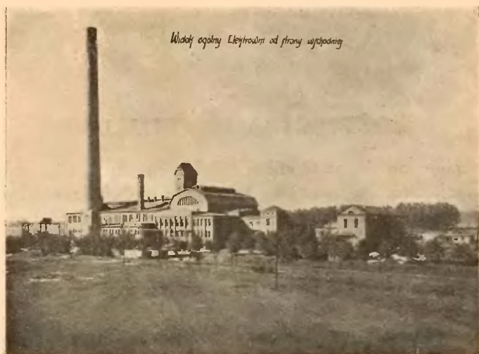
Elektrownia Okręgowa Zagłębia Dąbrowskiego.
