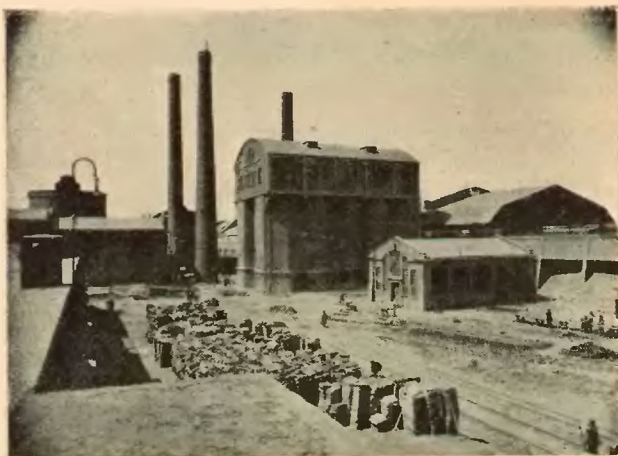
Zakł. Przemysł. „Solvay”. Fragment cementowni.
