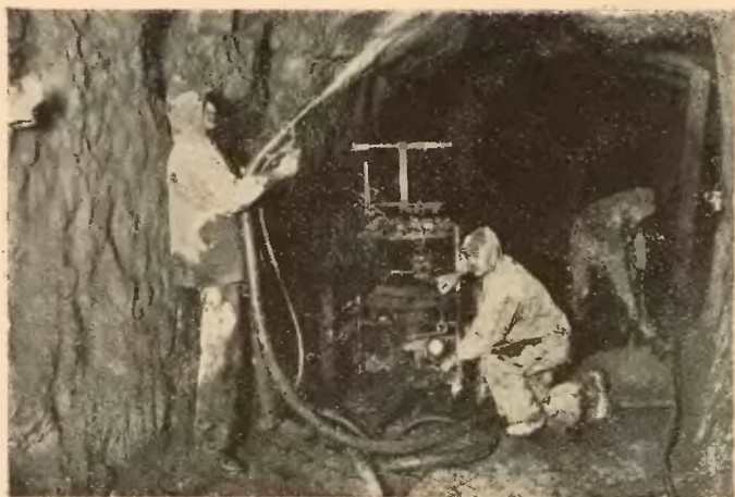
Cementowanie chodnika na kop. „Grodziec II”.
