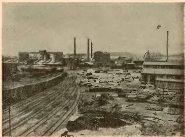
Zakł. Przemysł. „Solvay”. Widok cementowni.
