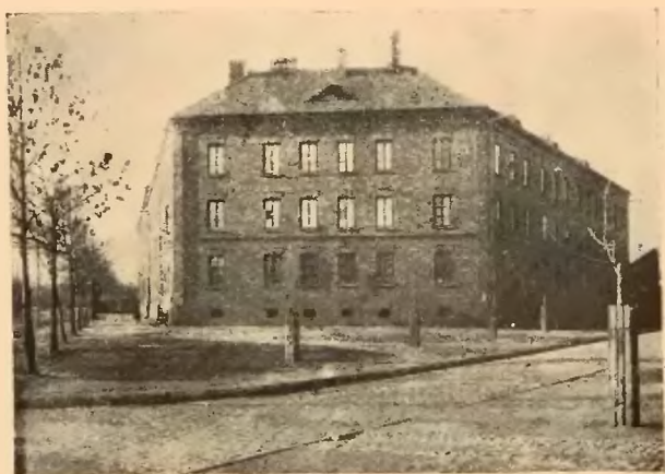
Gmach Biblioteki i Sali gimnastyczn. Grodzieckiego T-wa.
