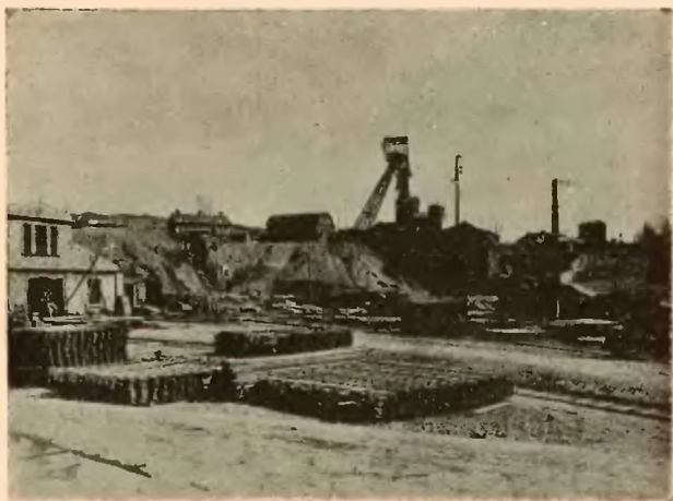
Zakł. Przemysł. „Solvay” — Kopalnia Grodziec I“
