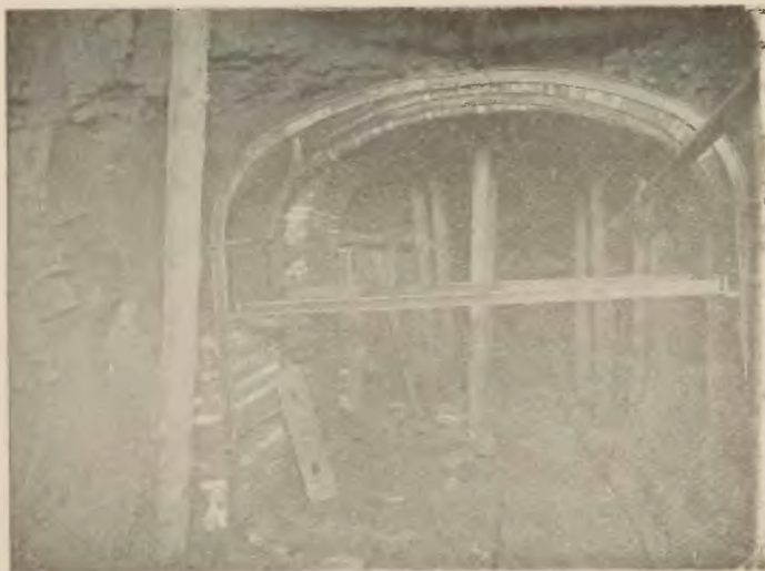
Kop. „Jowisz”. Obudowa podziemnych wyrobisk betonitami.
