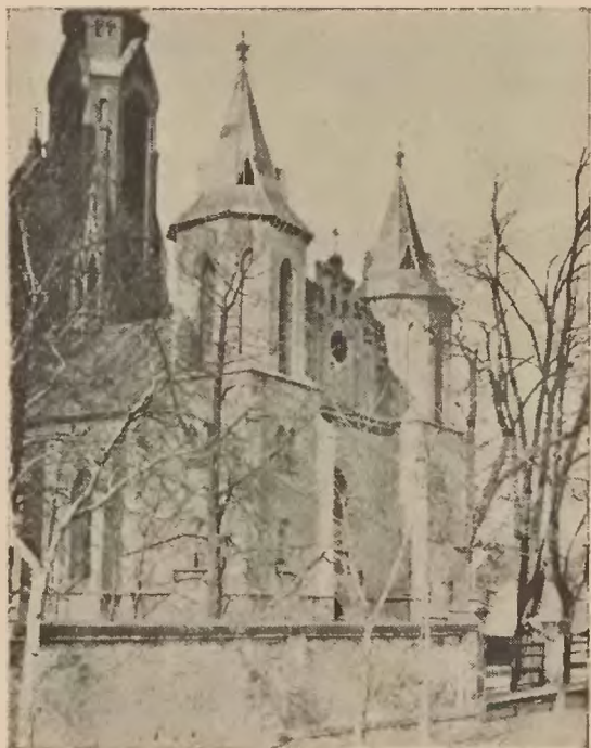
Pierwotny kościół parafjalny zbudowany przez Jadwigę Mieroszewską.
