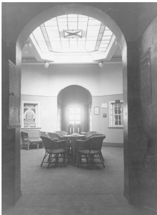
Fot. 23. Poczekalnia dla pasażerów na lotnisku cywilnym w Katowicach; proj. Lucjan Sikorski, Tadeusz Michejda, 1929 r. (zbiory Narodowego Archiwum Cyfrowego, sygn. 1-G-4093-2)
