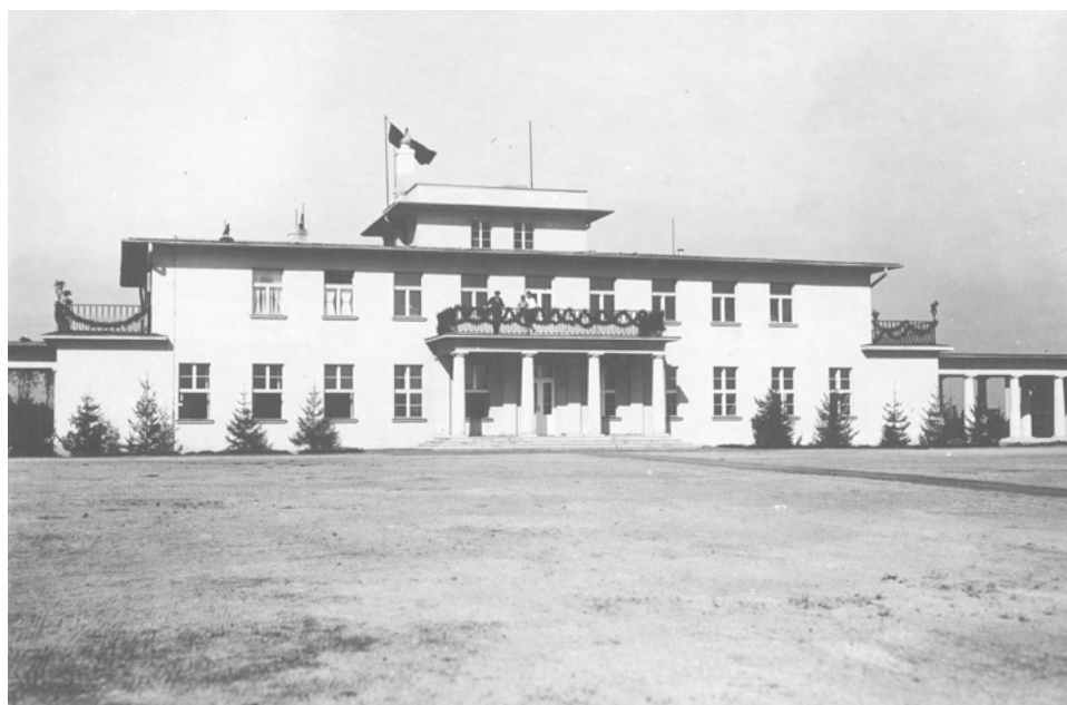
Fot. 24. Lotnisko cywilne w Katowicach; proj. Lucjan Sikorski, Tadeusz Michejda. Widok ogólny głównego budynku lotniska (zbiory Narodowego Archiwum Cyfrowego, sygn. 1-G-4094-2)
