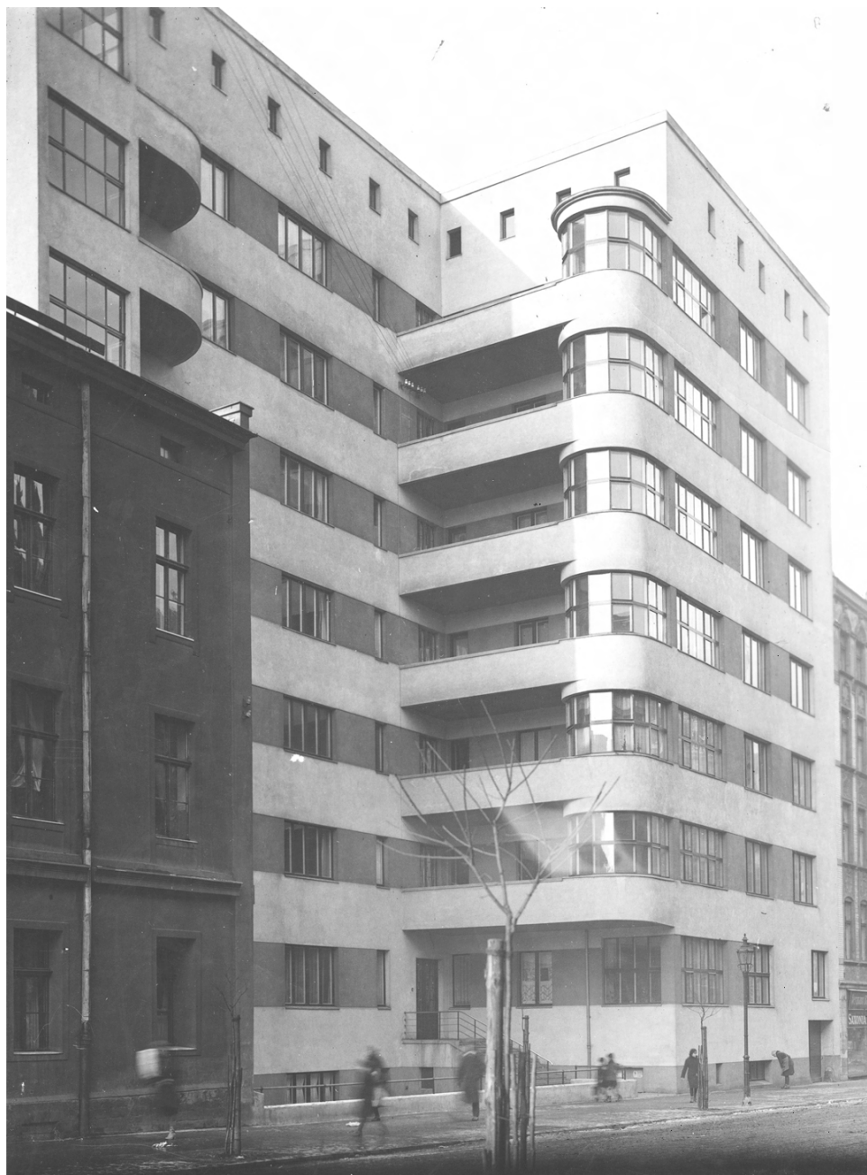
Fot. 20. Dom mieszkalny pracowników kolejowych przy ul. J. Słowackiego w Katowicach; proj. Tadeusz Michejda (zbiory Narodowego Archiwum Cyfrowego, sygn. 1-U-2057)
