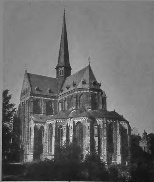
69. Zisterzienserkirche von Osten. Doberan.
