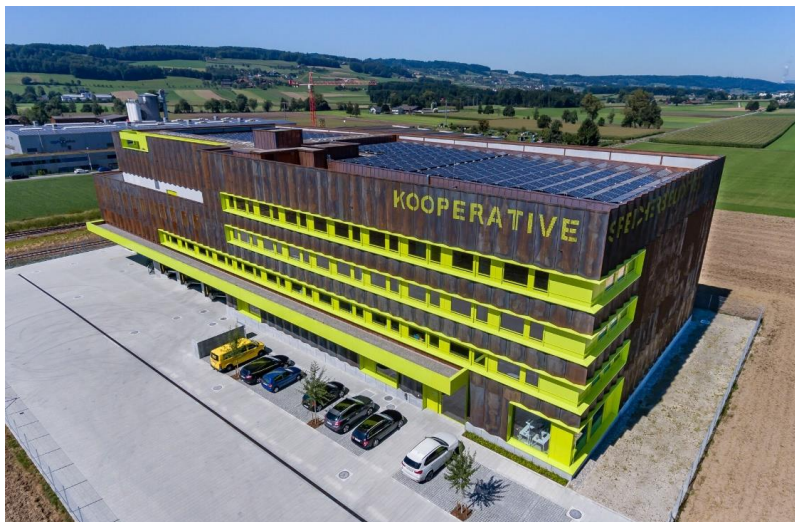
Fot. 12. Magazyn w Büron - budynek
