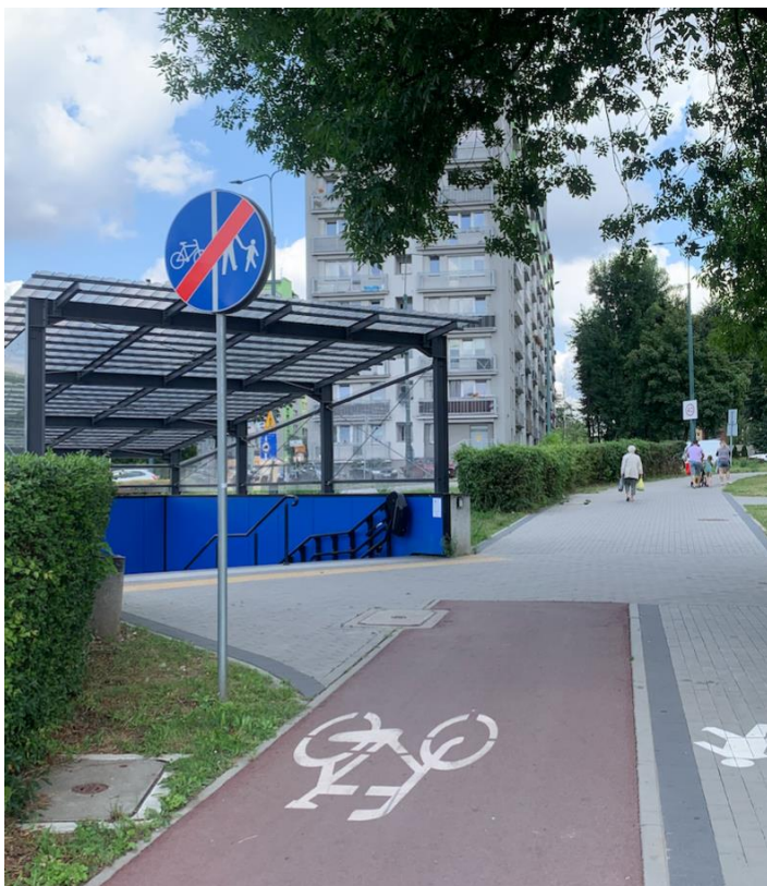
Fotografia 2. Koniec drogi rowerowej – Sosnowiec, ul. J. Piłsudskiego, 2023 rok
