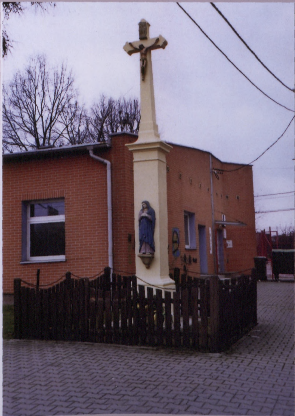
Zarzecze, 08.04.2012 r. Ul. Gen. S. Grota Roweckiego przy bud. nr 20 Krzyż kamienny z końca XIX w. na cokole i kolumnie. Na kolumnie figura Matki Boskiej Bolesnej.
