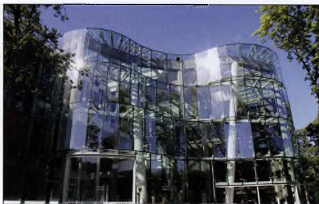
Zmodernizowany budynek Filharmonii Opolskiej im. Józefa Elsnera w Opolu
