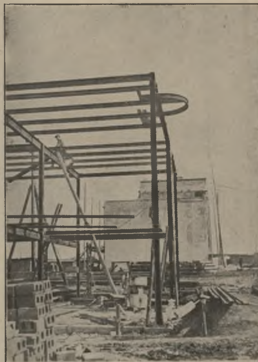
Fragment budowy domków o szkielecie żelaznym w Siemianowicach
