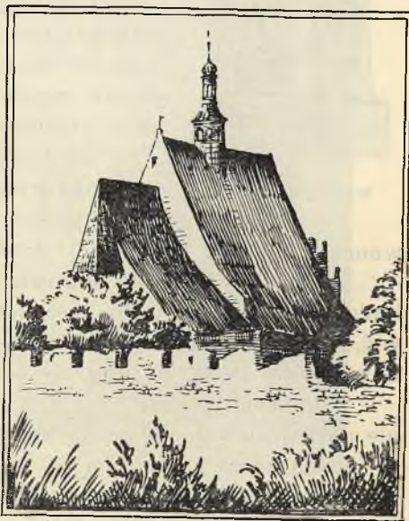
KOŚCIÓŁ MUROWANY W SZYDLÓWIE
