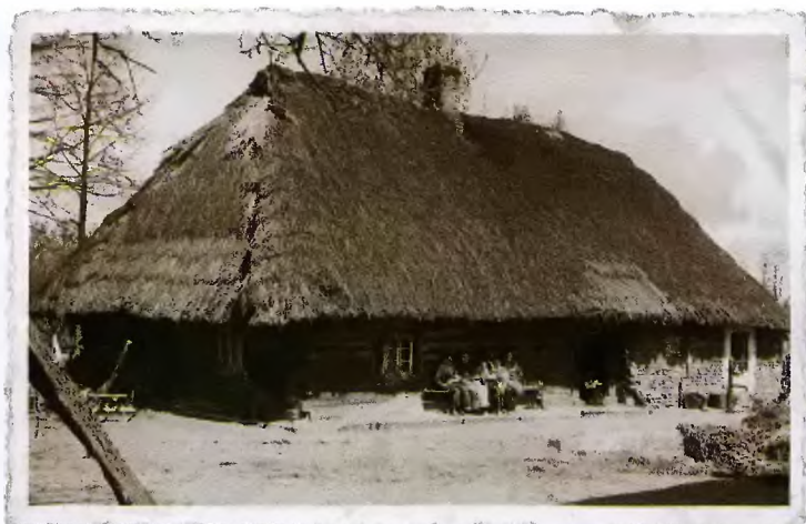
Domostwo Gruski-Ścibika (1942 r.). Ściany wykonane z drewnianych bali, strzecha słomiana. Dolna część szczytowej połaci dachu wraz z jej krawędzią poszytą snopkami „główczokami”, reszta nakryta snopkami „płaszczokami”. Obok domu stała zbudowana w układzie południkowym ośmioboczna drewniana stodoła również nakryta słomą, natomiast równoległe do domostwa (po przeciwnej stronie podwórka) była obora. Kilka tego rodzaju chłopskich zagród, typowych dla przełomu XVIII i XIX wieku przetrwało w Kryrach do połowy XX stulecia. Od poł. XIX wieku domy i obory wznoszono już tylko z cegły, którą chłopcy produkowali sami. Dachy nadal jeszcze wówczas kryto słomą, którą od końca tamtego wieku zaczęła powoli wypierać dachówka i papa. Nie znamy u nas przypadku krycia zabudowań gontami (szyndziolami).
