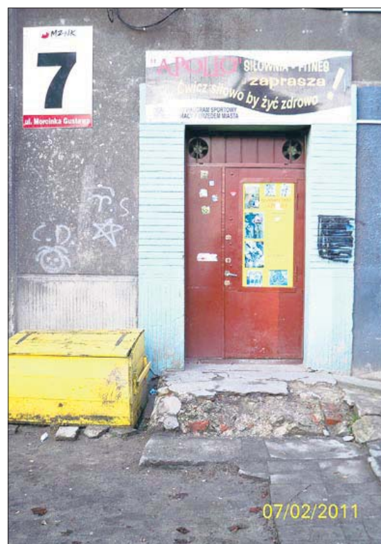
MORCINKA 7. Budowla schodo-podobna
