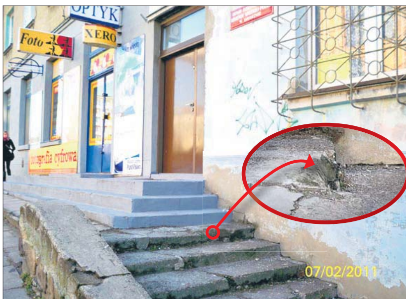
POSTERUNEK PRZY KOLBEGO. Remont schodów na 50 procent
