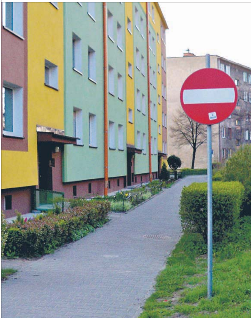
Blok przy ul. Plac św. Jana 1. Rodzaj i szerokość nawierzchni widocznego traktu wskazuje na ciąg pieszy. Po co więc znak dla pojazdów? Czyżby zdarzyło się, że korzystały z niego pojazdy?
