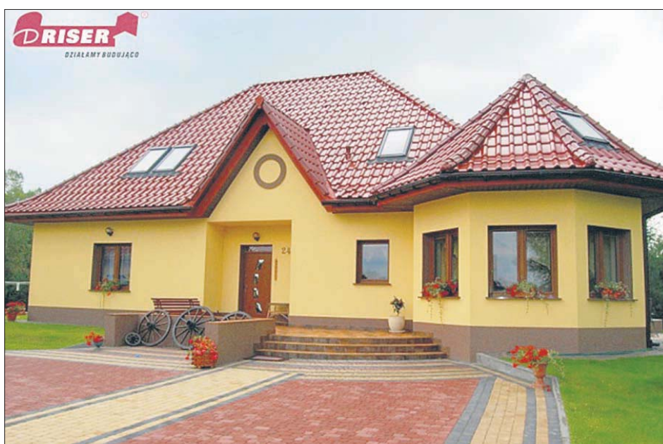
Dom wybudowany w Jaworznie przez firmę RISER Sp. z o.o.
