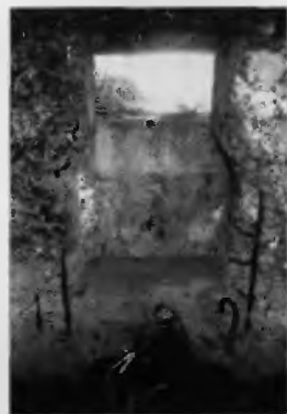
Wnętrze schronu bojowego na pozycji obronnej pod Pszczyną. Widoczne pręty zbrojeniowe \phi 10 i \phi 20 mm – stan obecny
