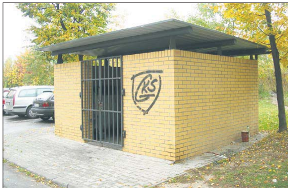
Przy Wielkiej Skotnicy 34 zamiast zsympu jest śmietnik na zewnątrz budynku
