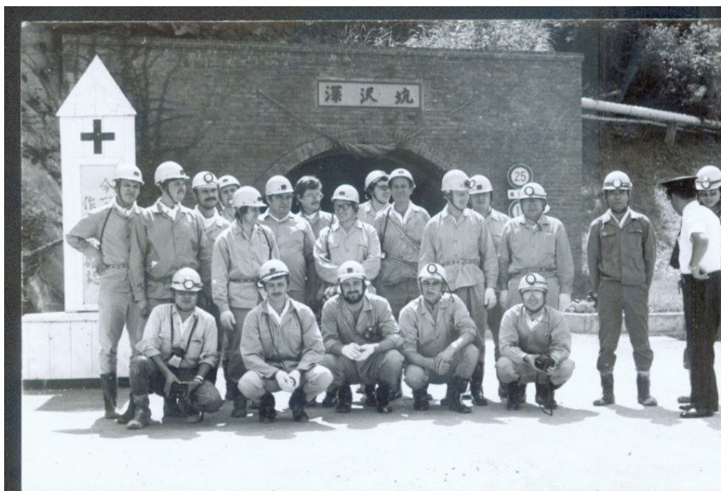
Foto. 35. Przed wizytacją budowy najdłuższego w świecie tunelu kolejowego „Seikan” pomiędzy wyspami Honsiu i Hokkaido – sierpień 1978
