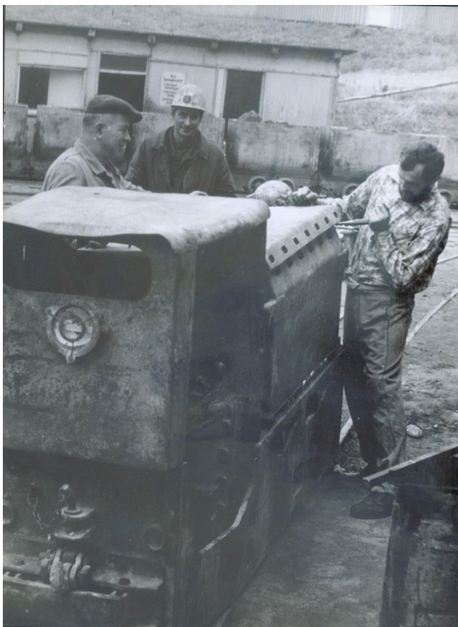
Foto. 15. Student (z prawej) ściśle wykonuje polecenia mechaników w warsztacie na placu budowy sztolni wodnej „Burkersdorf” (lato 1977)
