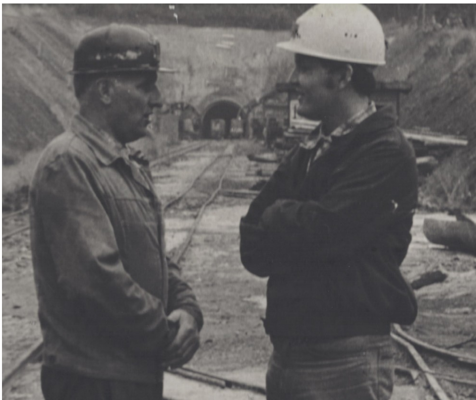
Foto. 29. Narada przed szczytą u wlotu do sztolni wodnej „Burkersdorf” – NRD Kierownik praktyki dr inż. B. Barchański (z prawej) i szef robót strzałowych A. Śnieżko (lato 1975)
