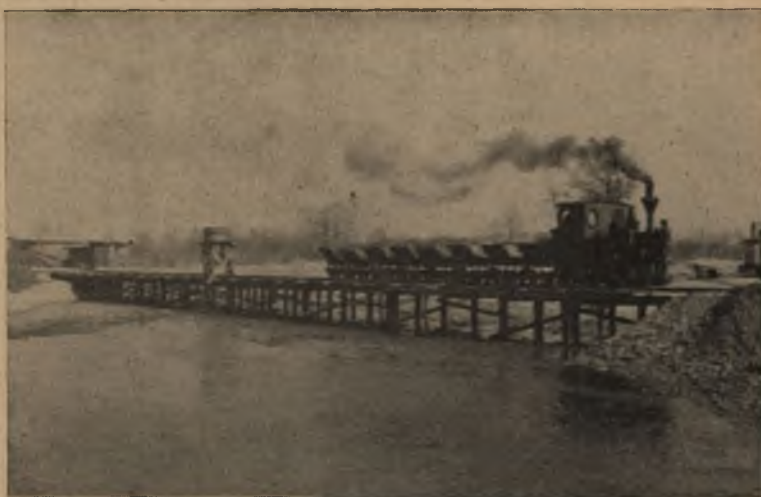
Felder-Entkiesung und Deichherstellung bei Baißen
