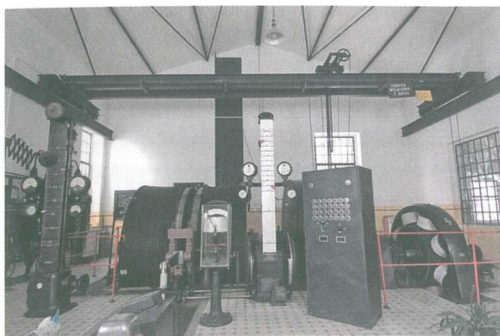
31. Zabrze, Szyb Maciej. Maszyna wyciągowa po pracach konserwatorskich, fot. Z. Barecki 2013 r.
