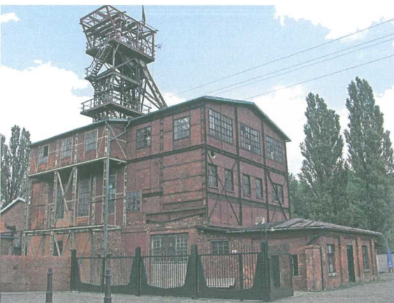
16. Zabrze, Szyb Maciej, budynki – nadszybia i wagowni przed pracami konserwatorskimi, elewacja frontowa, fot. P. Muschalik, 2005 r.
