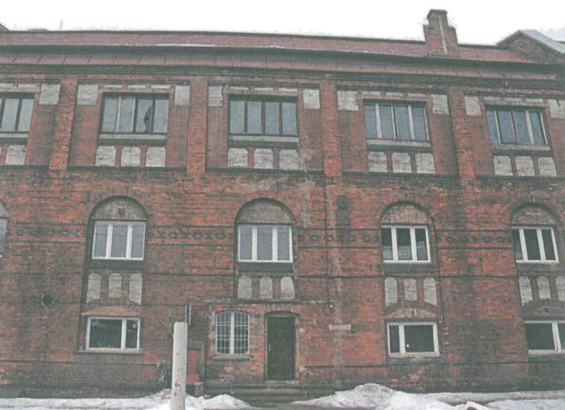
Zabrze, budynek d. kopalni Ludwigsglück, budynek d. szatni, łaźni, cechowni (markowni) przed pracami konserwatorskimi, elewacja frontowa, fot. D. Żabicka-Barecka, 2010 r.
