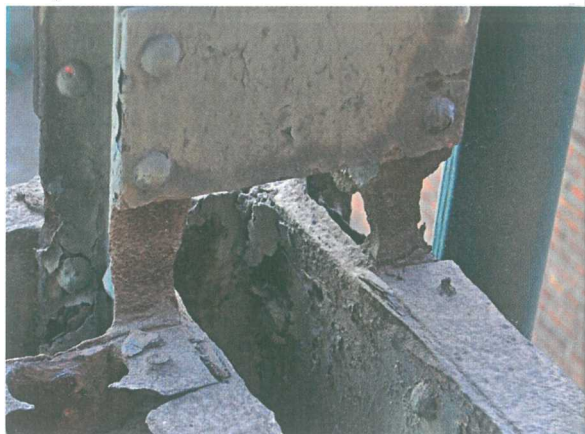
17. Zabrze, Szyb Maciej, budynek nadszybia przed pracami konserwatorskimi, wnętrza, fot. D. Żabicka-Barecka 2005 r.
