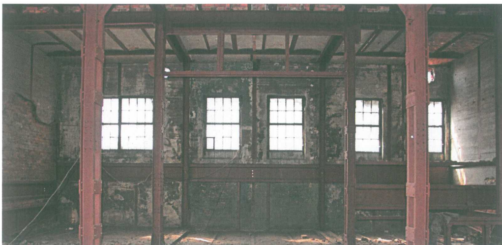
18. Zabrze, Szyb Maciej, budynek nadszybia przed pracami konserwatorskimi, konstrukcja od strony frontowej, fot. D. Żabicka-Barecka 2005 r.
