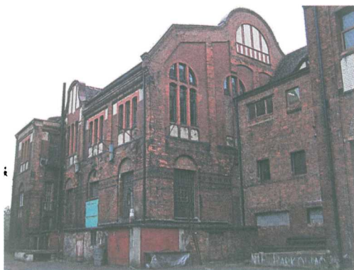
Zabrze, budynek d. kopalni Ludwigsglück, budynek d. szatni, łaźni, cechowni (markowni) przed pracami konserwatorskimi, elewacja tylna, fot. D. Żabicka-Barecka, 2010 r.
