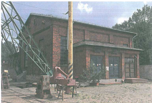
20. Zabrze, Szyb Maciej, budynek maszyny wyciągowej przed pracami konserwatorskimi, elewacja boczna i frontowa, fot. D. Żabicka-Barecka, 2009 r.
