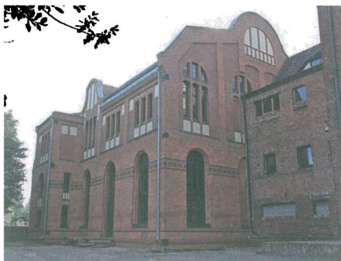
Zabrze, budynek d. kopalni Ludwigsglück, budynek d. szatni, łaźni, cechowni (markowni) po pracach konserwatorskich, elewacja tylna, fot. D. Żabicka-Barecka, 2013 r.
