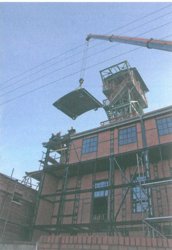
22. Zabrze, Szyb Maciej, budynek nadszybia – prace adaptacyjne, montaż zadaszenia nad szybem dźwigu osobowego, fot. D. Żabicka-Barecka, 2012 r.
