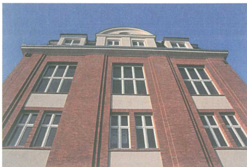
7. Zabrze, budynek d. hotelu robotniczego Kopalni Ludwigsglück „Dom Kawalera” po pracach konserwatorskich, elewacja południowa, fot. D. Żabicka-Barecka, 2009 r.
