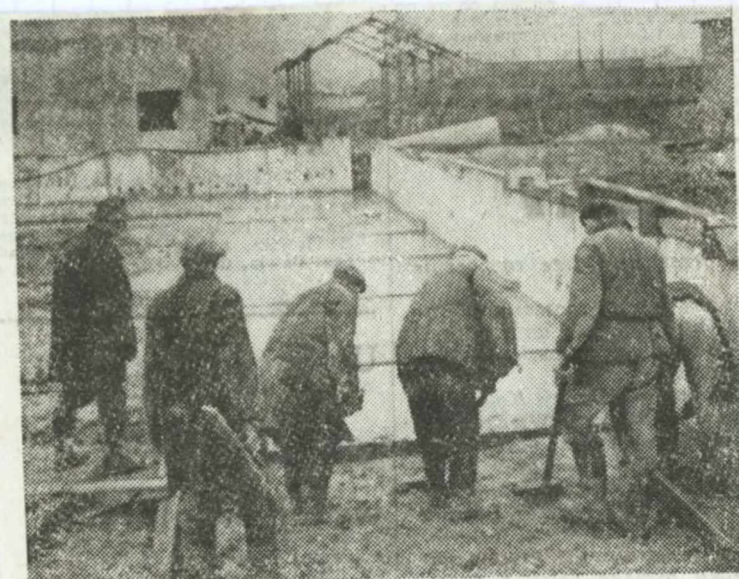
NA ZDJĘCIU: utwardzanie składowiska opału. Konstrukcja o zarysach domku widoczna w głębi — jest to tzw. kosz przyjęciowy do mechanicznego rozładunku wagonów. Na razie jest to tylko surowa konstrukcja. (cz) Zdjęcia: J. Jez
