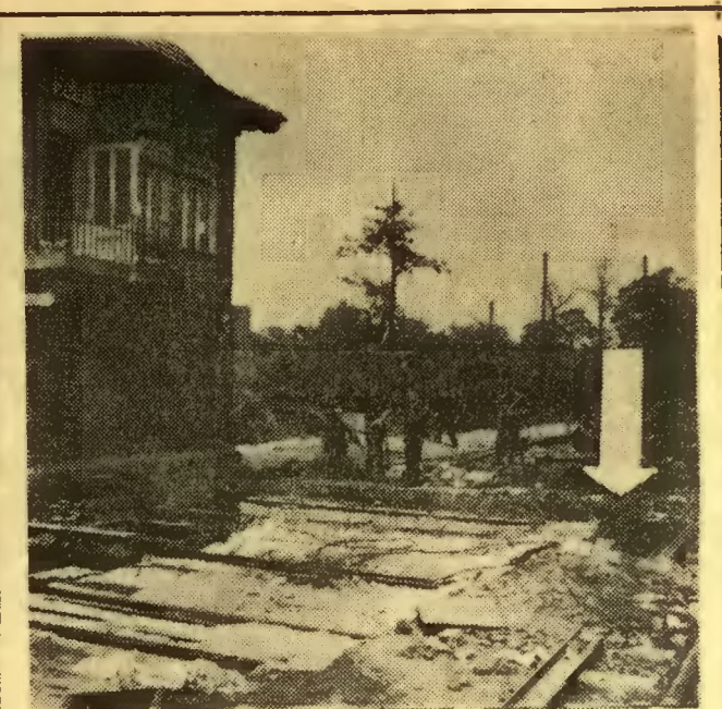
Z miejsca oznaczonego białą strzałką przesunięto budynek nastawni na miejsce na którym stoi.
