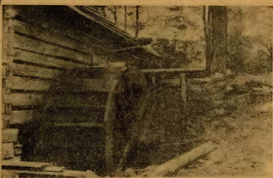
Młynskie koło w Brennej poruszane siłą wody potoku Jajny.
