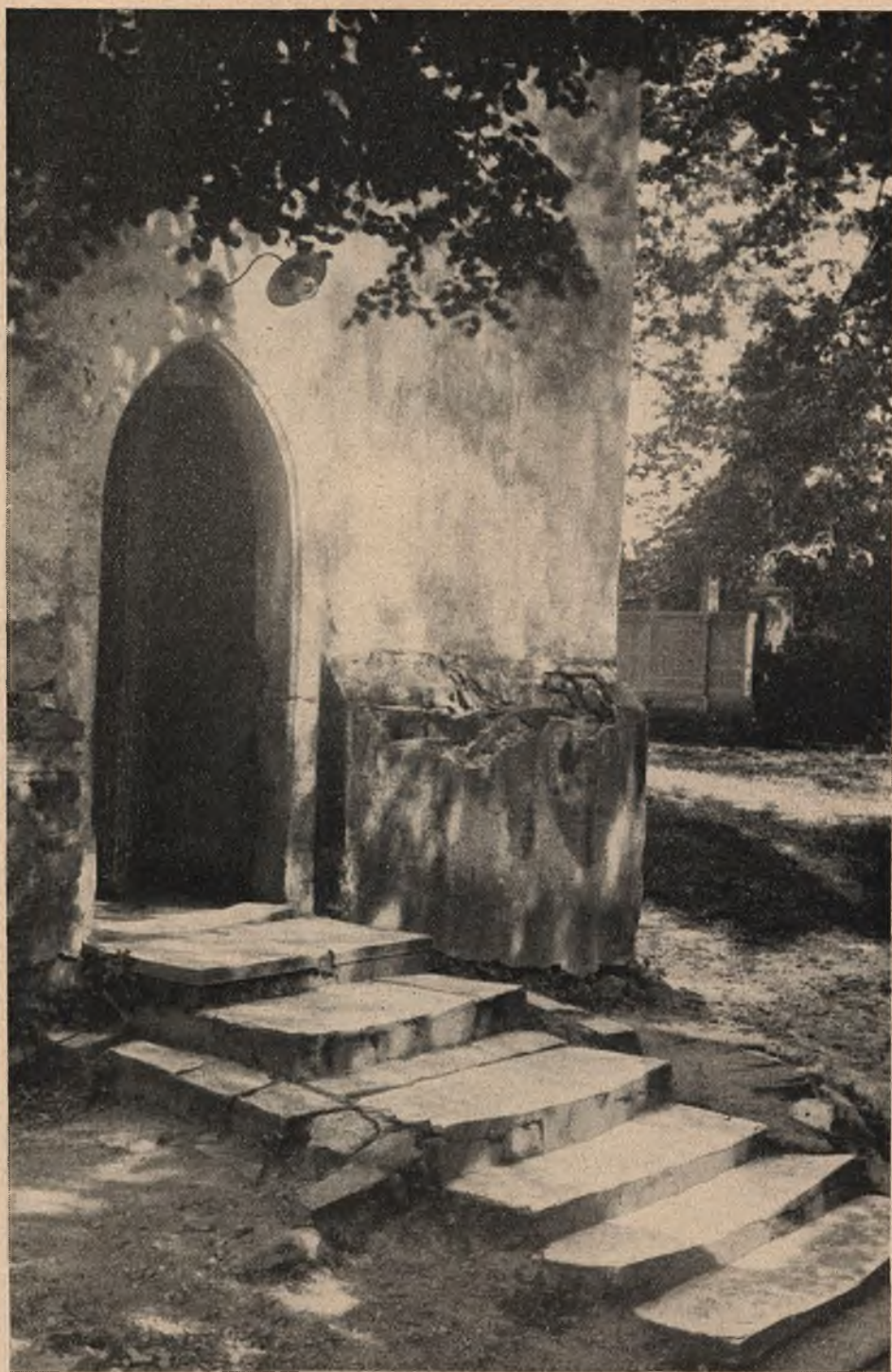
Eingang zur Altvetter Kirche vor dem Umbau
