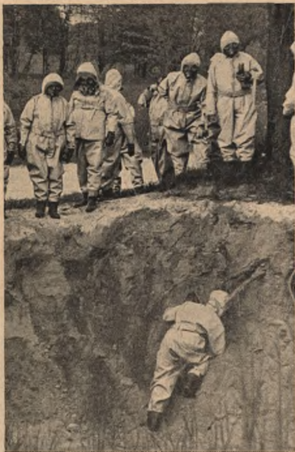
Gaspiiren im Sprengtrichter
