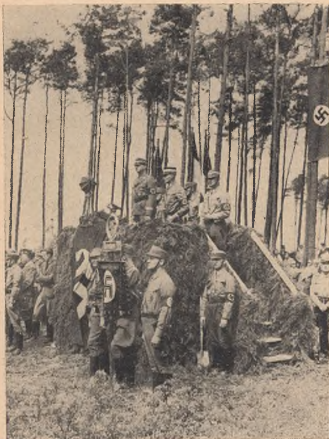
Stabschef Lutze in Eichenkamp bei der Grundsteinlegung am 9. Mai 1937
