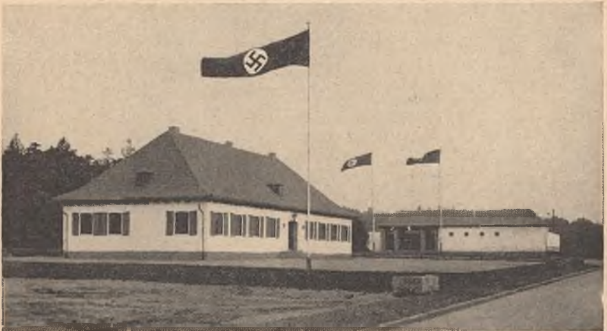
Laband: Das erste Heim der HJ. im Industriegebiet (im Hintergrund Eingang zur Kampfbahn).
