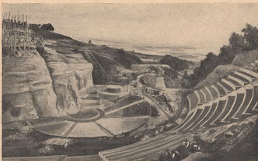
Gerherd Neumann: Bau der Feierstätte am Annaberg
