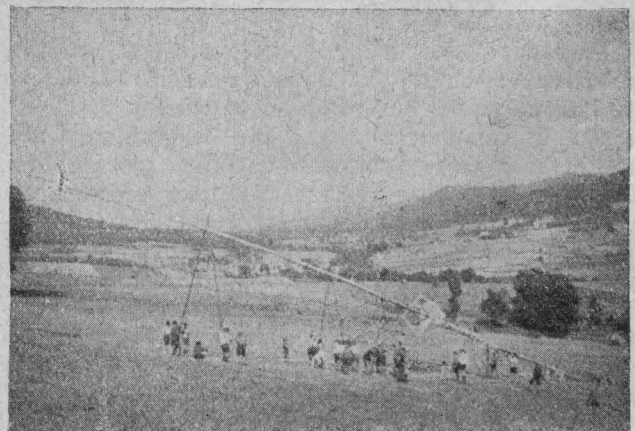
Stawianie masztu głównego na wielkiej polanie Bucza.
