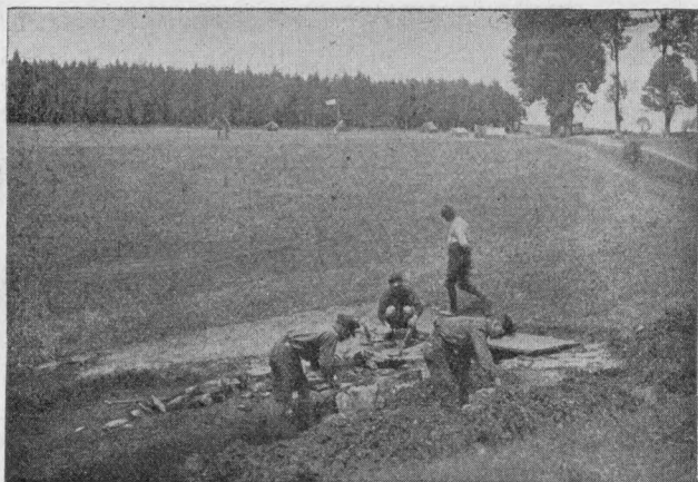
Bucze — budowa studzienki.
