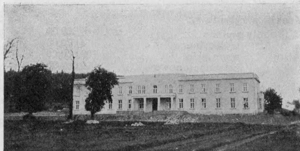
Gmach główny „Bucze“ po przebudowie.
