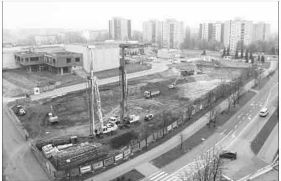
Prace budowlane ruszyły pełną parą (fot.rs)
