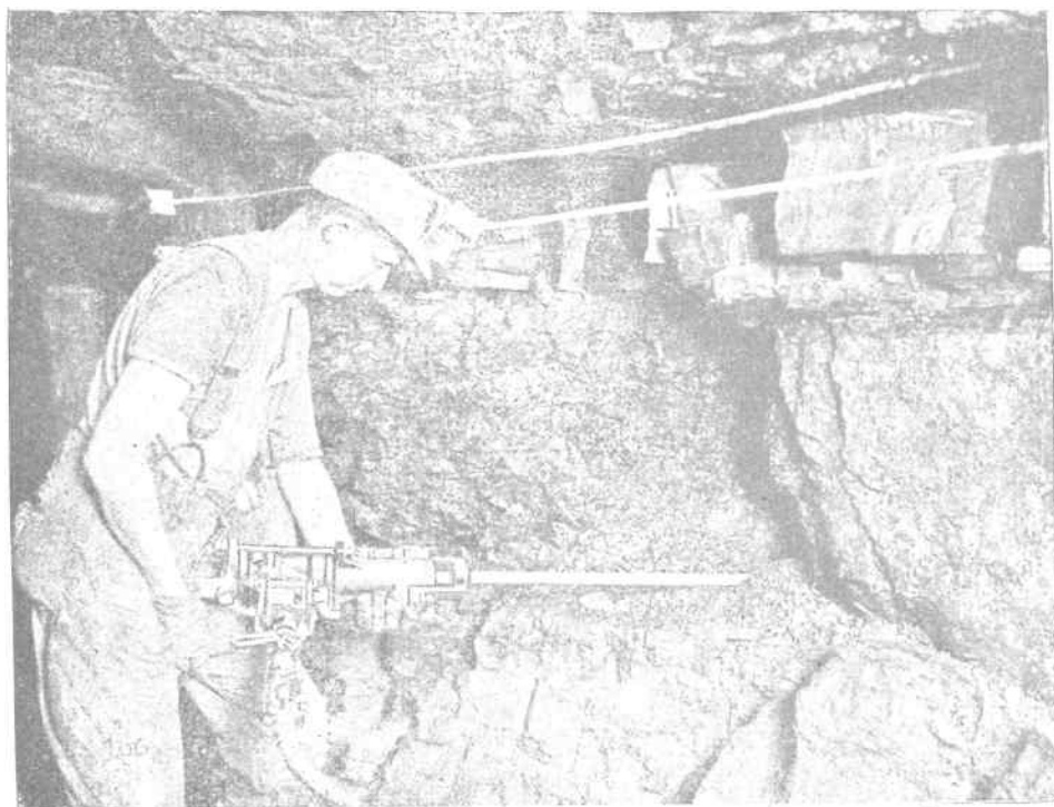
Wiercenie otworów w przodku wiertarką udarową Rys. 169
