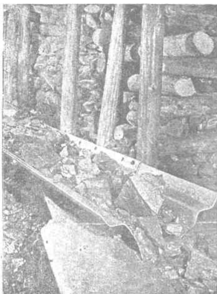
Wylot przenośnika wstrząsanego Rys. 298
