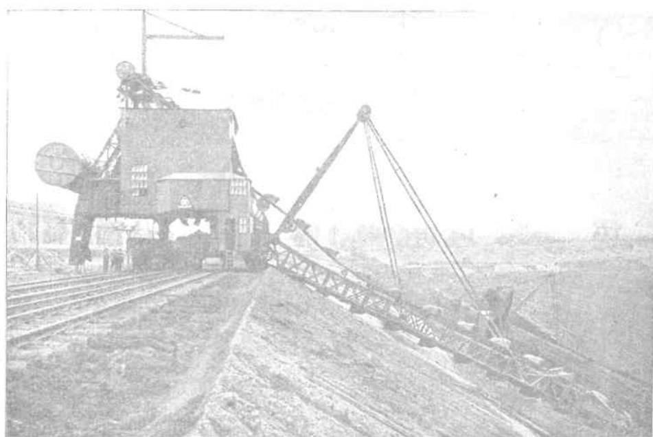
Czerparka wieloczerpakowa podpoziomowa Rys. 160
