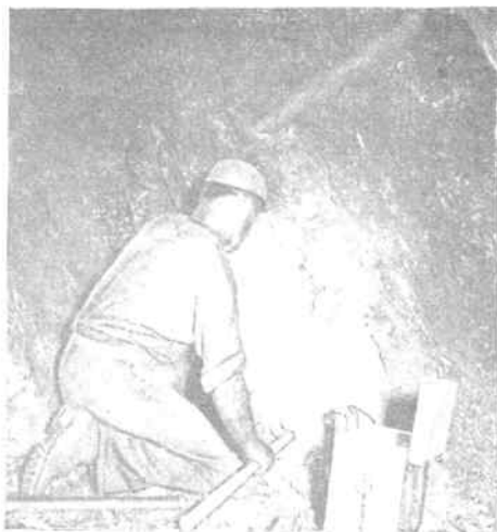
Ładowanie otworu strzałowego
