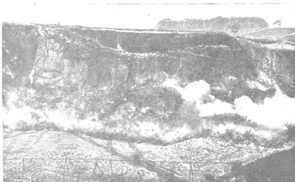
Odstrzał komorowy ładunku. 2200 kg materiału wybuchowego.
