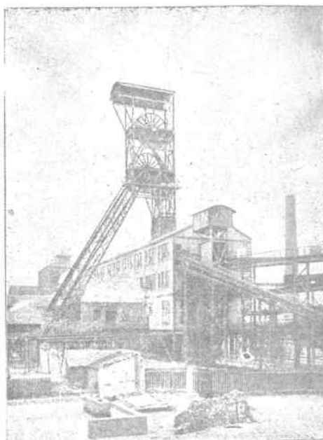
Wieża szybowa z kołami linowymi na różnych poziomach Rys. 366
