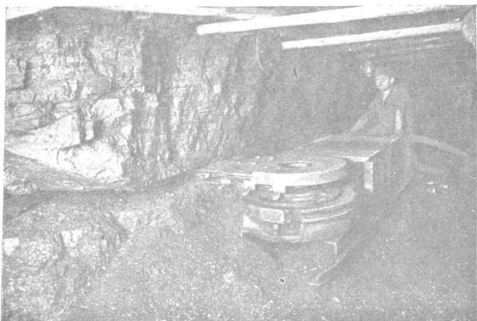
Wrębiarka łańcuchowa na ścianie
