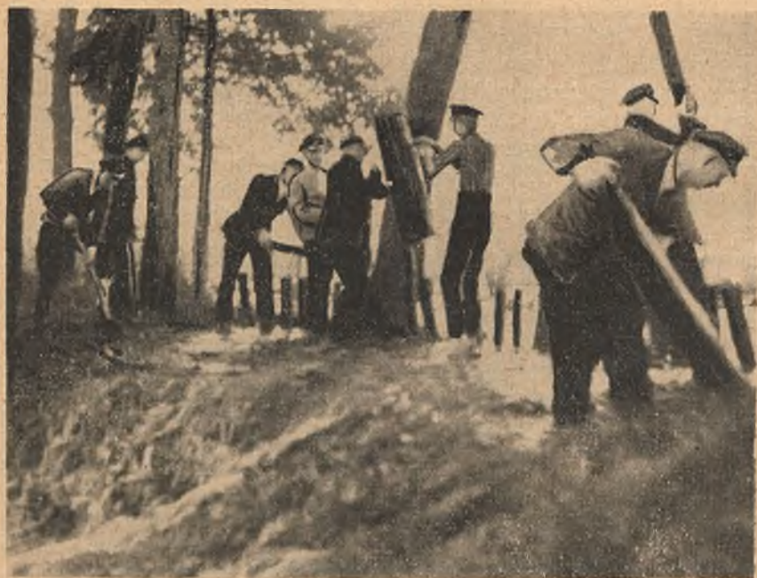
Technische Nothilfe verstärkt den Schutzdamm
