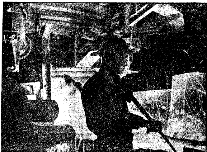
Wszędzie przemysł niemiecki pracuje. — Ilustracja nasza przedstawia moment wlewania płynnego żelaza do formy.
