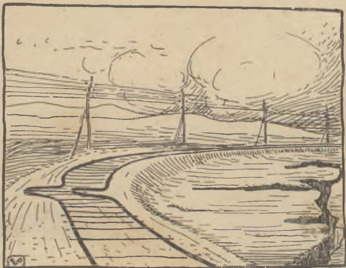
Widoczek okolicy, nawiedzonej przez trzęsienie ziemi. Szyny kolei żelaznej zostały pocięte, a w ziemi (na prawo) potworzyły się głębokie szczeliny.
