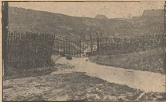
Chauſſeebau bei Smolnitz.
