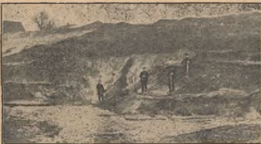
Chauſſeebau bei Smolnitz.
