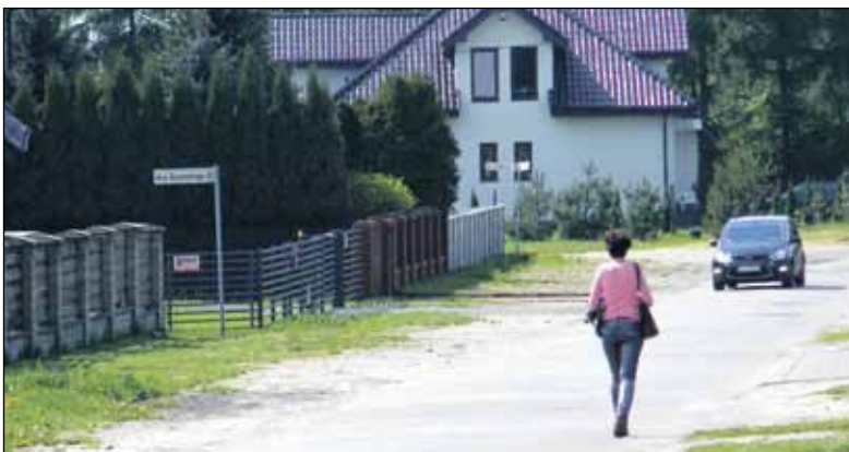
Ul. Prusa ma zyskać nową podbudowę i nawierzchnię, zbudowany przy niej będzie także chodnik.
