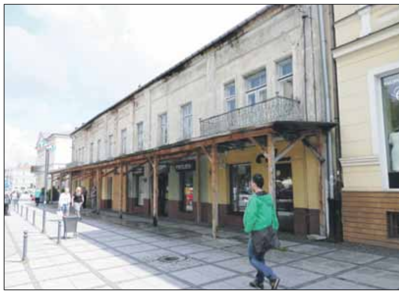
W tym miejscu stanąć ma pięciokondygnacyjny obiekt usługowo-handlowy. Będzie tu pasować?
