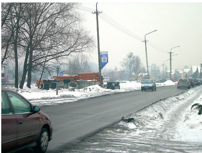
Przebudowa ulicy Ciężarowej i Wiślańskiej w Skoczowie.
