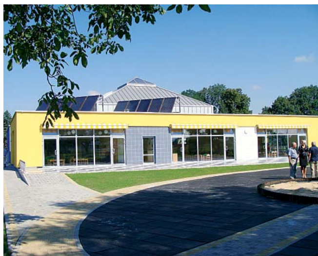
Na dachu przedszkola zamontowano kolektory słoneczne.
