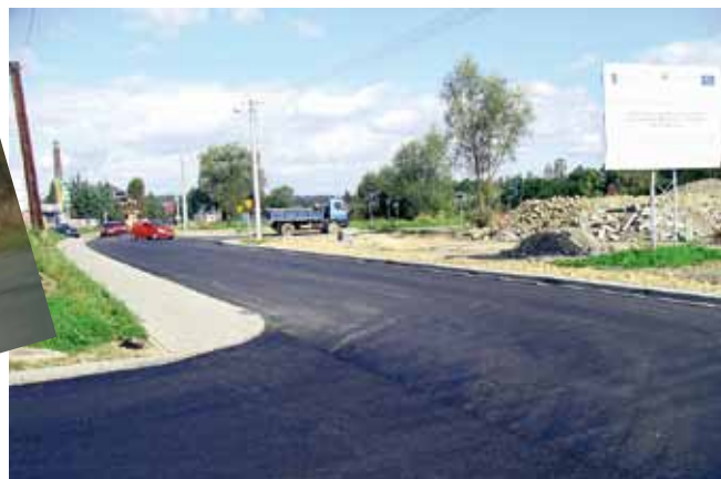
Ulica Wiślańska przebudowana wraz z ulicą Ciężarówką w Skoczowie w latach 2009-2010. Współfinansowana ze środków UE.
