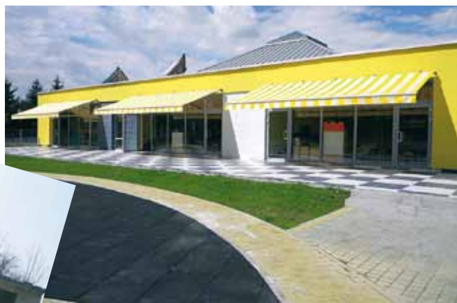
Przedszkole w Ochabach. Budowa w latach 2009-2010. Współfinansowana ze środków UE.
