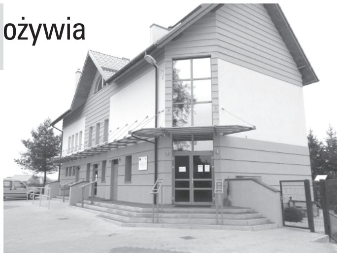
Domu Rolnika został podwyższony, dobudowana została obszerna klatka schodowa i pomieszczenia kuchni.
